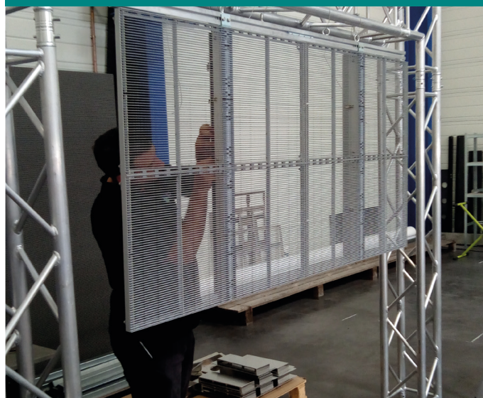
Installation NS au départ du sol
